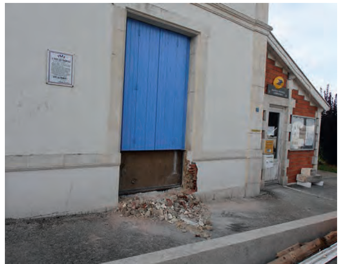
TRANSFORMATION DE LA FENETRE EN PORTE
